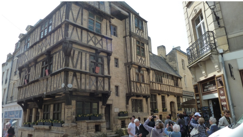
1-7 Une des belles maisons médiévales à colombages et encorbellements. Maison typique de l'époque avec base en pierres surmonté de pans de bois et de torchis
