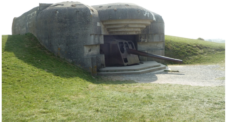
1-14 Une des quatre pièces d'artillerie sous casemate
